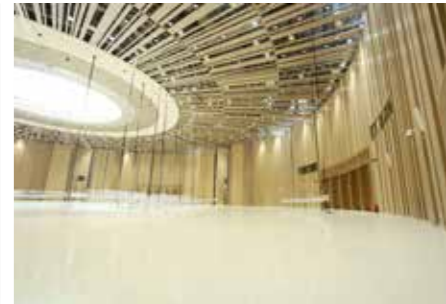
Slät pigmenterad polyuretanbeläggning: 2 mm
