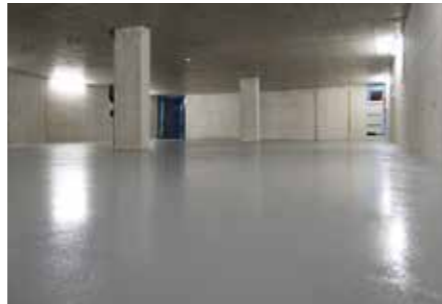
Halkskyddad, pigmenterad epoxibeläggning: 2-4 mm
