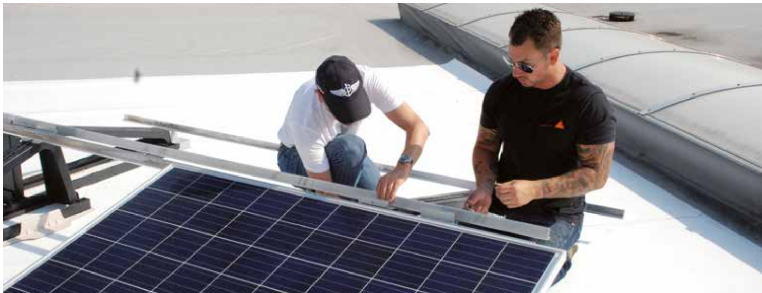
Montage av solceller på Vit Sarnafil TS 77-20 SR (Solar Reflection), SRI=111.
