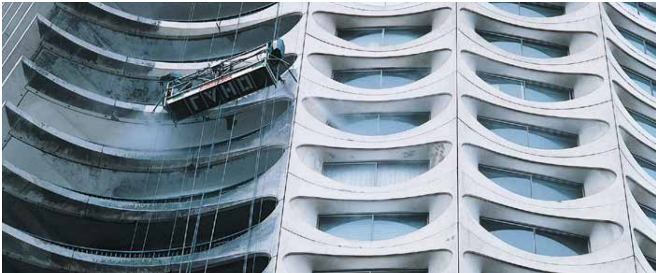
REFURBISMENT Reparation och skydd av armerad betong med Sika
