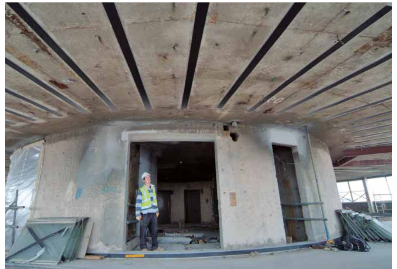
REFURBISMENT Reparation och skydd av armerad betong med Sika
