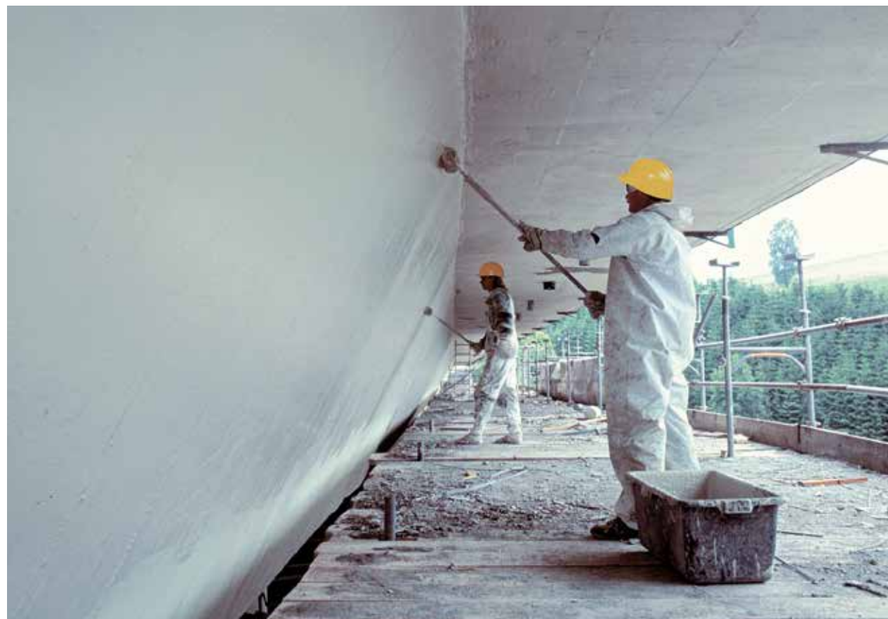
REFURBISMENT Reparation och skydd av armerad betong med Sika
