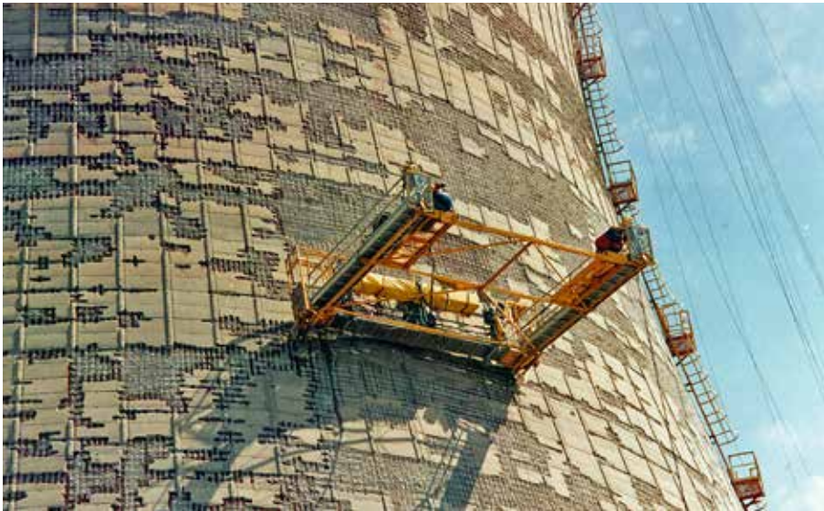
REFURBISMENT Reparation och skydd av armerad betong med Sika
