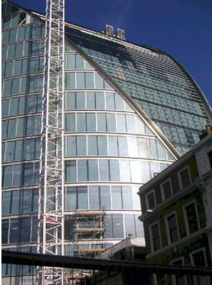
Typisk Curtain Wall fasad anno 2004.
