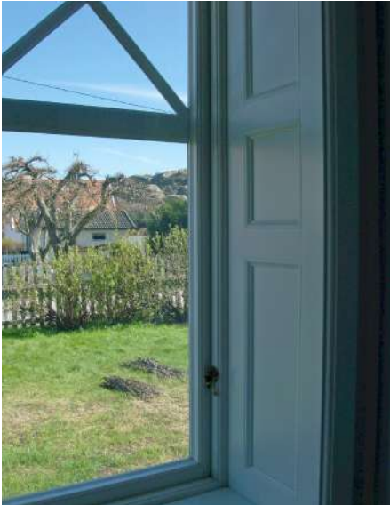
Traditionellt kopplat 2-glasfönster med slanka profiler. Foto: Thim Petttersson
