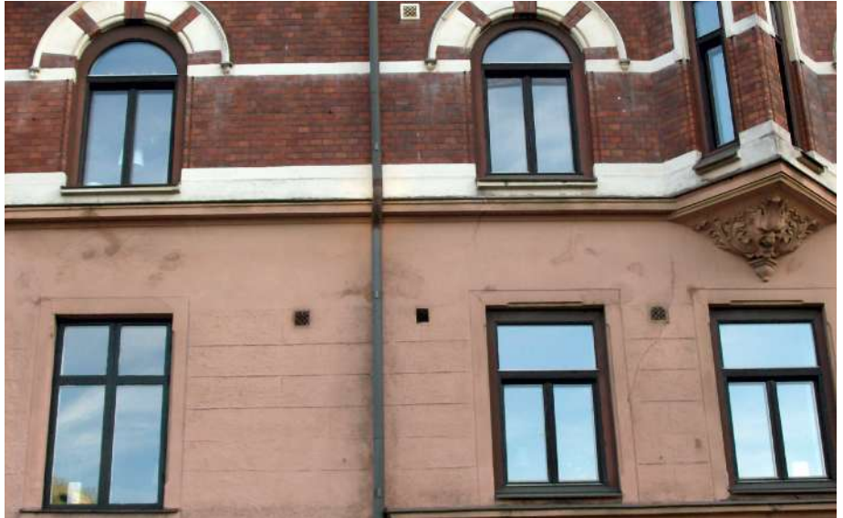
Flera felaktigt mått-satta insticksfönster med allt för breda täcklistor ger felaktig arkitektur och för lite dagsljus. Ett originalfönster till vänster. Foto: Thim Petttersson
