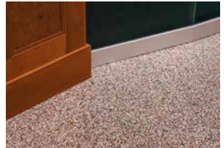
Halkskyddad, pigmenterad epoxibeläggning: 2-4 mm
