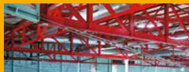
KORROSION OCH BRANDSKYDD
