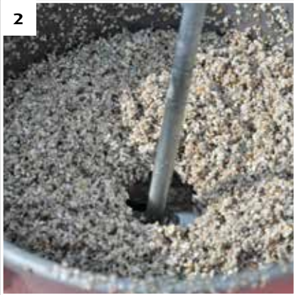
Steg 2: Blanda de båda SCHÖNOX® EP DRAIN-komponenterna och blanda därefter epoxikomponenten med sand SCHÖNOX® MONOCORN 2-3mm
