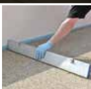
Applicering av SCHÖNOX® EP Drain.
