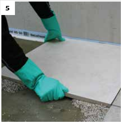
Steg 5: Lägg plattan i murbrukshögar
