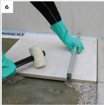
Steg 6: Justera plattornas position med en gummihammare och ett vattenpass
