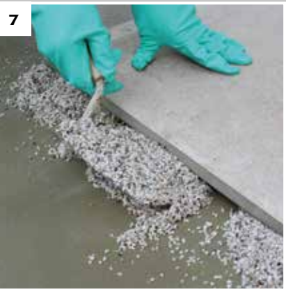
Steg 7: Fyll kanterna under plattan.
