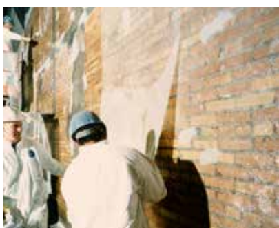
FÖRSTÄRKNING AV SEISMISKA SKADOR
