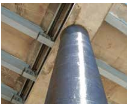
FÖRSTÄRKNING AV PELARE
