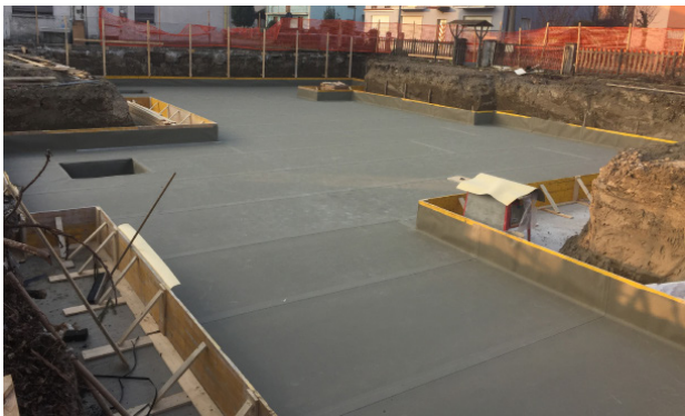
Typisk installation av SikaProof® A+ på betongplatta.
