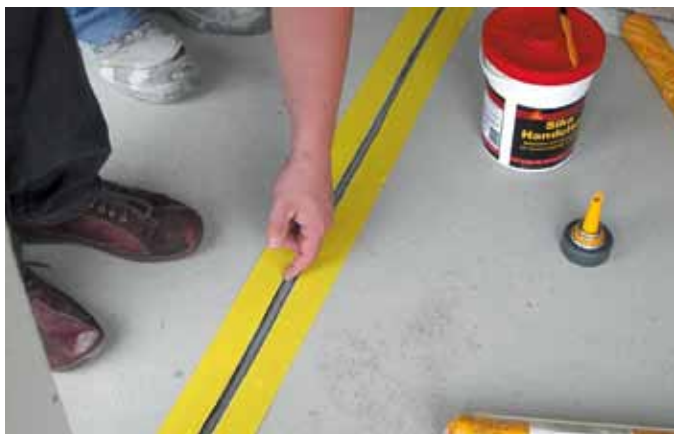
Montering av bottningslisten
