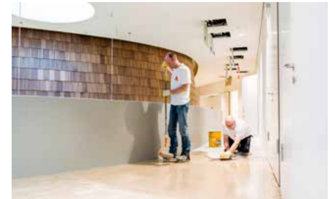
STEG 2. En flytande primer appliceras för att ge god vidhäftning för golvbeläggningen. Detta görs normalt med gummiraka eller roller. Rätt metod kan väljas med ledning av undergolvetns egenskaper.
