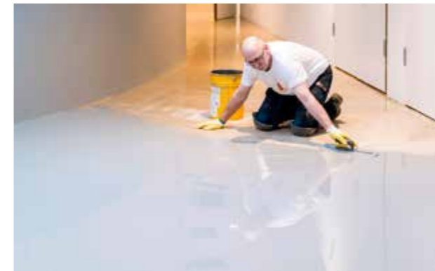
STEG 3. Självutjämnande material appliceras i ett eller flera lager och bildar ett fogfritt underlag. Det flytande materialet hålls ut och fördelas av specialister med hjälp av speciella rakor och pigroller så att ytan blir fullständigt jämn och slät.
