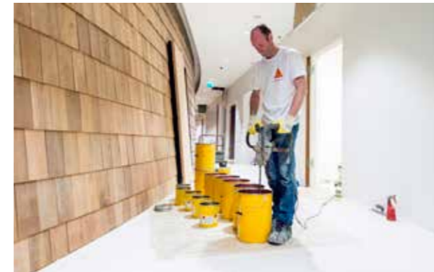
STEG 1. När undergolvet har kontrollerats och förbehandlats genom rengöring och vid behov blästring, slipning och/eller avjämnning ska våra flytande material blandas till.
