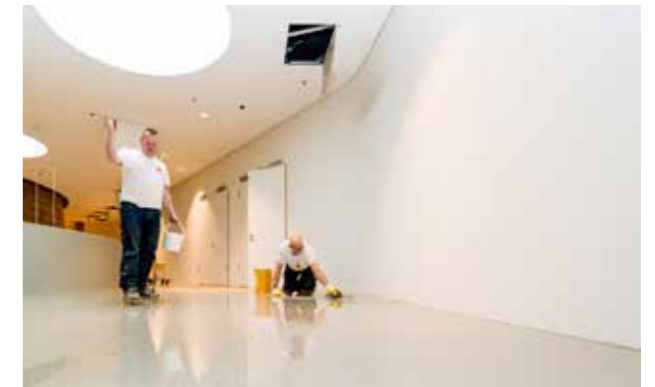
STEG 4. Välj mellan ett stort antal flytande härdplaster som passar till en rad olika användningsområden och finns i ett praktiskt taget obegränsat antal kulörer. Dekorativa flingor eller halkskyddspartiklar kan strös på den våta ytan.
