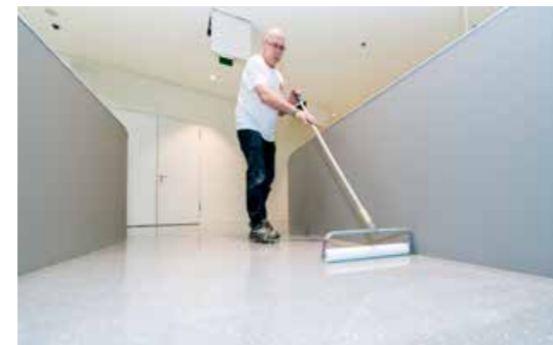
STEG 5. Det hela avslutas genom att ett genomskinligt eller pigmenterat ytskikt läggs ut. Appliceringen sker normalt med roller. Ytskiktet garanterar att golvet får önskat utseende och tillför dessutom friktions- och halkskyddsegenskaper till golvet.
