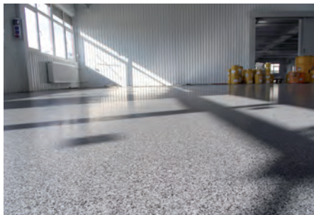
Uppräströad färgsandsbeläggning: 2-3 mm
