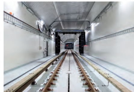
Halkskyddad, pigmenterad epoxibeläggning: 2-4 mm
