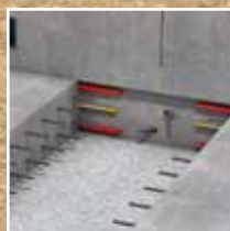
Anslutningsfog mellan slitsmur och bottenplatta
