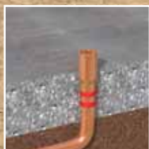
Tätning av genomföringar
