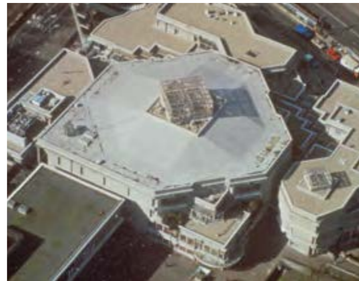
Project year: 1988 | Muziekcentrum Vredenburg, Utrecht Netherland | Sarnafil® G 442-15; Sarnafil® S 327-12
