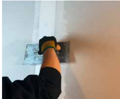
2. Spackla skarvar och skruvhål med Casco WallCraft .
