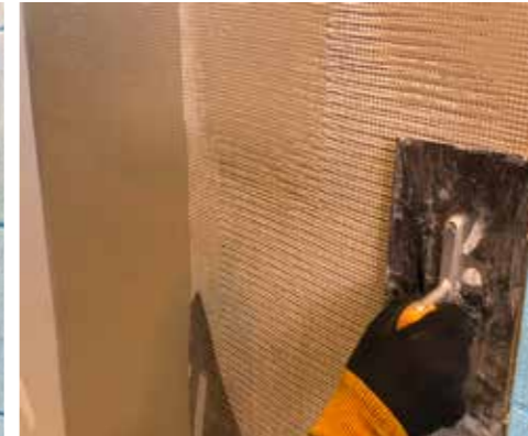
1-2. Installera SCHÖNOX Folie 1 eller 2 enligt gällande monteringsanvisning. Låt torka. Spackla väggen med SCHÖNOX Q8 och armeringsnät Sika Armatop . Skrapa in nätet i fästmassan och täck nätet. Överlappa nätet med 100 mm. Låt torka.
