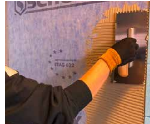
1-2. Installera SCHÖNOX Folie 1 eller 2 enligt gällande monteringsanvisning. Låt torka. Spackla väggen med SCHÖNOX Q8 och armeringsnät Sika Armatop . Skrapa in nätet i fästmassan och täck nätet. Överlappa nätet med 100 mm. Låt torka.
