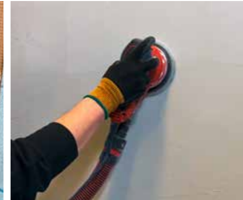
3. Slipa till önskad yta. Ibland kan ytterligare ett tunt lager behöva spacklas för att armeringsnätet inte ska synas igenom.
